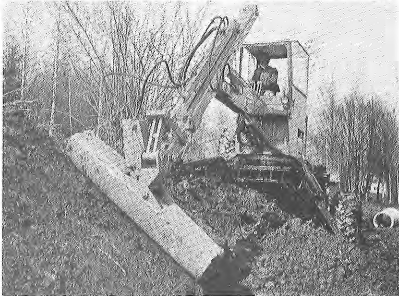
1977 Produktion des Menzi Muck 3000-T2 mit einem 2 m teleskopierbaren Ausleger
